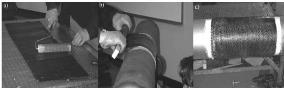
شکل ۵ - مراحل تعمیر لوله آسیب دیده به روش تر
